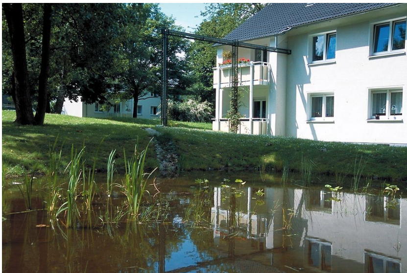
Mulde zur Speicherung und Versickerung von Regenwasser
