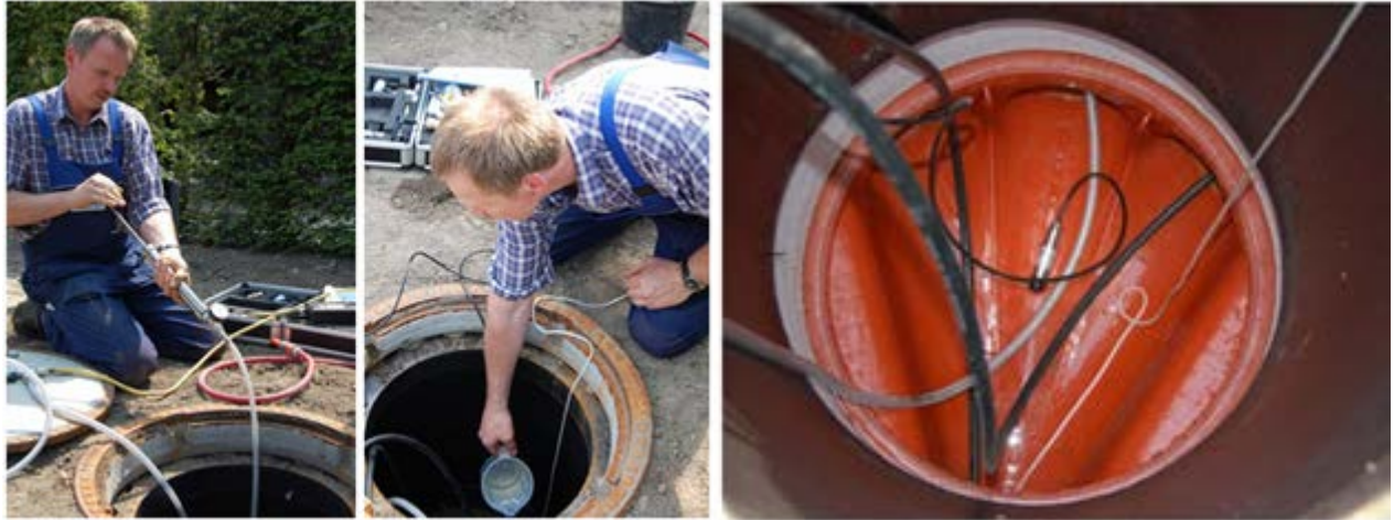
Durchführung einer Dichtheitsprüfung - Bildbeispiel
