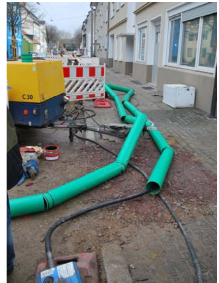
vorbereiteter Rohrstrang für Einzug
