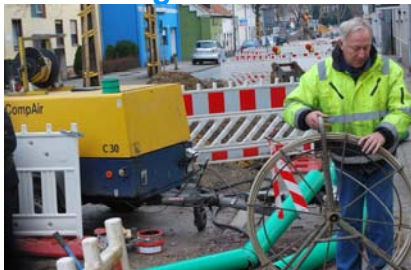
Vorbereitung Einzug Stahlseil
