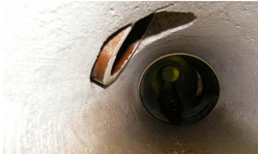
...eine der Testaufgaben: Stutzenreparatur - am unsanierten Hauptkanal
