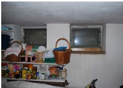
kaum Überflutung durchs Fenster
