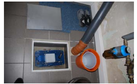
...neue Leitungen mit Revision
