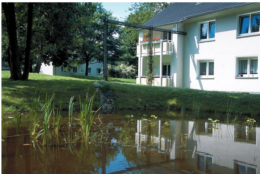
Mulde zur Speicherung und Versickerung von Regenwasser
